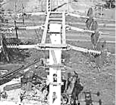
Jelenleg használatos madárvédelmi megoldások a hálózaton
